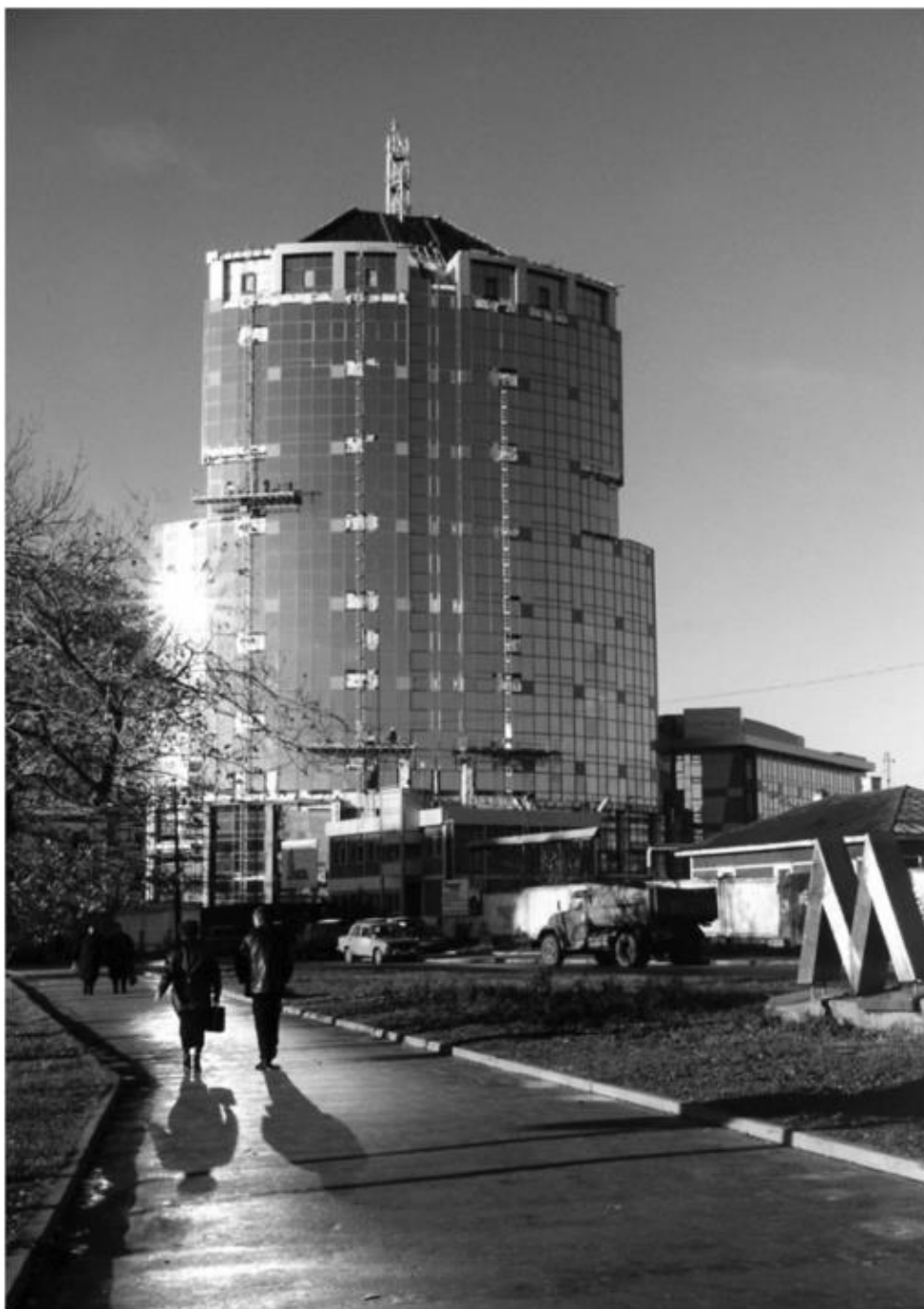
Рис. 4.3. Диспетчерский центр управления Свердловской железной дороги
